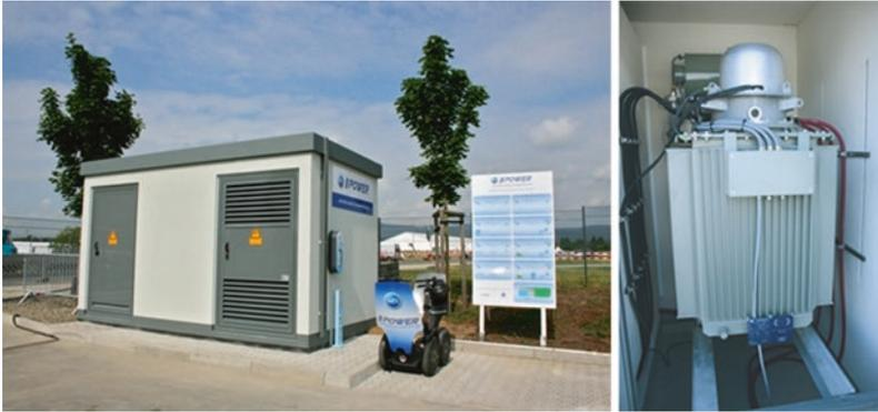
**Abb. 3.10** Ortsnetzstation mit regelbarem Ortsnetztransformator (rechtes Bild) zur Kopplung der Mittelspannungsebene (10 kV, 20 kV) mit der Niederspannungsebene 0,4 kV. (Quelle: Maschinenfabrik Reinhausen GmbH)
